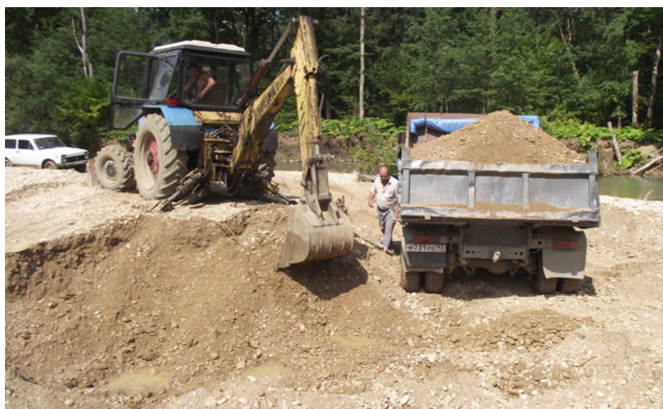
Рис. 1. – Открытая разработка месторождения песчано-гравийной смеси в Веденском районе ЧР
