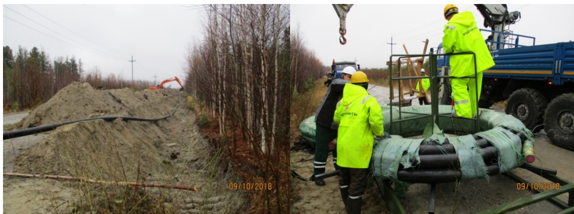
Рис. 4. Укладка и размотка секции гибких полимерно-армированных труб на объекте АО «Самотлорнефтегаз»
