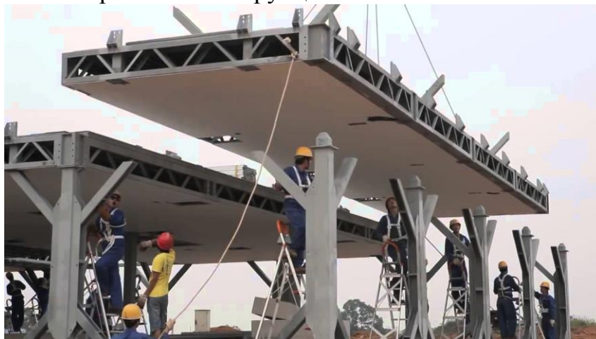
Рис. 1 – Монтаж стальных модулей
