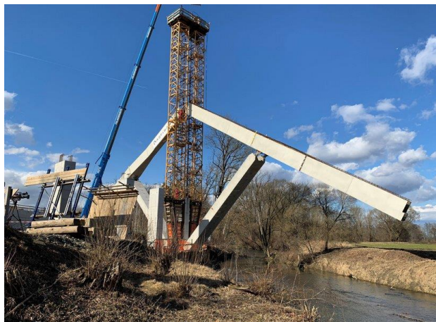
Рис. 3 – Возведение быстровозводимых мостов
