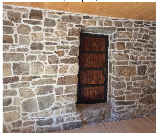
е) Внутренняя отделка
